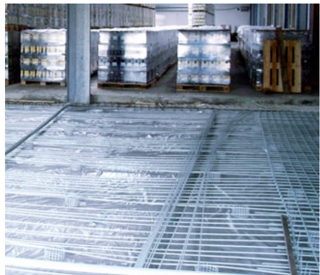
Einbau der GFRP-Bewehrung in der Fahrbahnplatte.
